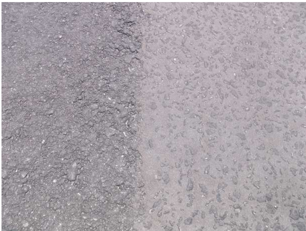
(拡大) 左：密粒度舗装、右：クールベープ・ファイン
