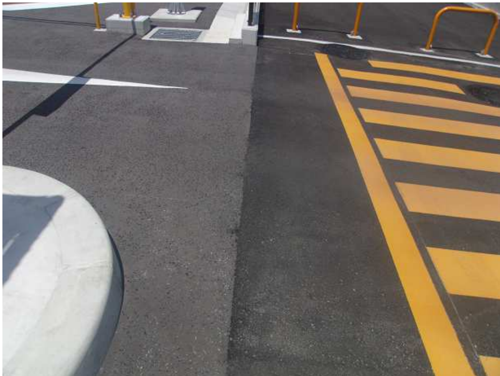
(拡大) 左：密粒度舗装、右：クールベープ・ファイン
