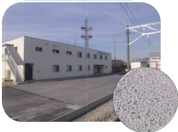
重車両走行路
