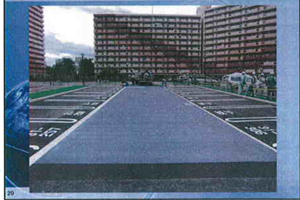
IRガード施工完了
