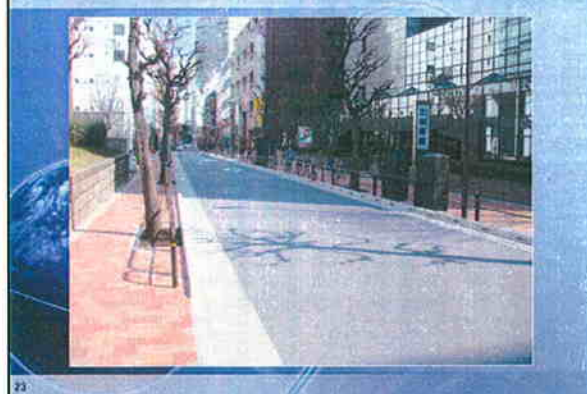
施工事例／お茶の水かえて通り (東京都)
