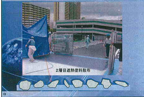
IRガードの施工
