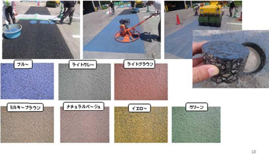
カラー透水性舗装ポーラス・ファインは、表面に骨材を飛散させないカラー樹脂混合物が圧入してあり、様々な色調を表現することが可能です。
