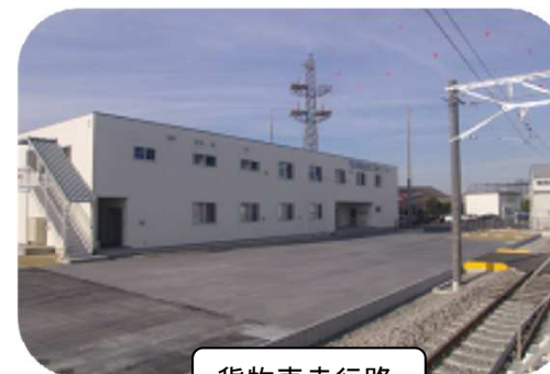
貨物車走行路
